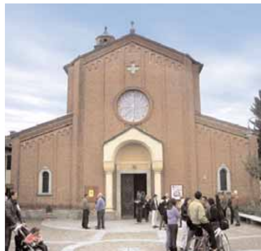
Parrocchia San Bernardo di Roata Chiusani.
