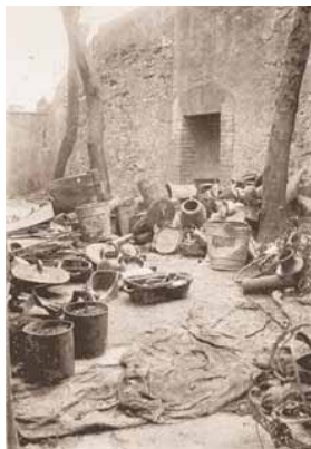
Accumulo di stoviglie dopo il bombardamento.
